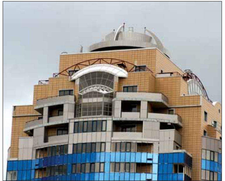
Навесные системы защищают стены от осадков и механических воздействий и облагораживают внешний облик здания
